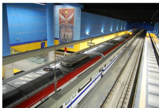
Una de las estaciones del nuevo Metro de Santo Domingo
