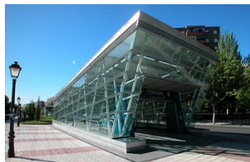
Escaleras dentro de un acceso cubierto, llamado templete.
