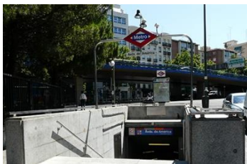
Escaleras por una entrada abierta a la calle.
