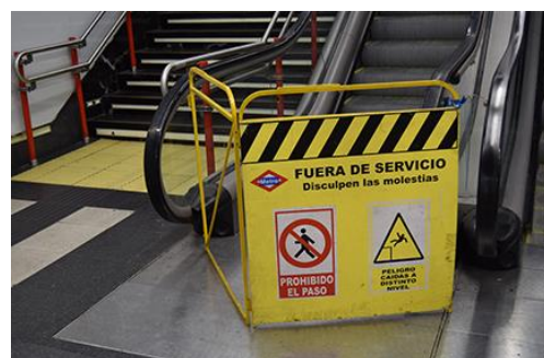
Esta señal indica que no puedes utilizar la escalera.
